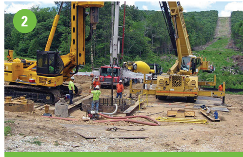
2 Drill hole and pour foundation
